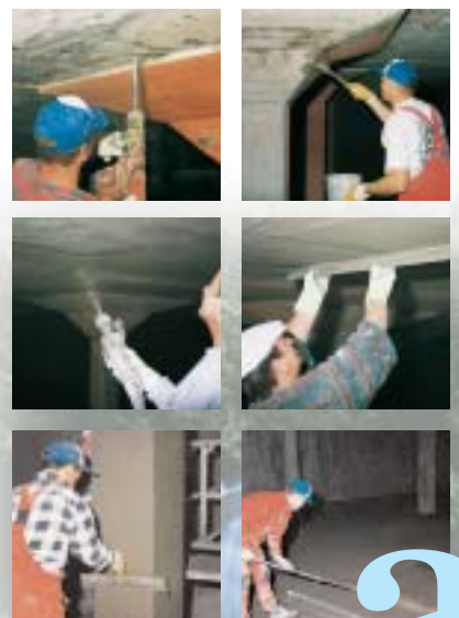
VANDEX UNIMÖRTEL VANDEX BB75 Aplikace strojní a ručně
