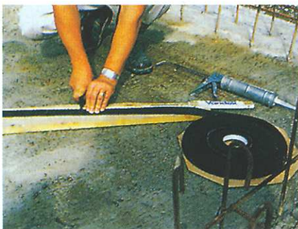
1. VANDEX EXPASEAL QUELLBAND se lehce nožem upraví na požadovanou délku.
