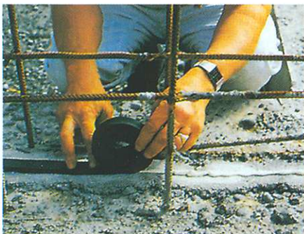
4. DETAIL: VANDEX EXPASEAL QUELLBAND je natlačen do nezatvrdlého lepidla.
