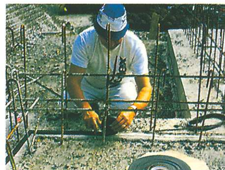
3. ... a VANDEX EXPASEAL QUELLBAND zatlačit do nezatvrdlého lepidla (položit do lepicího pole).
