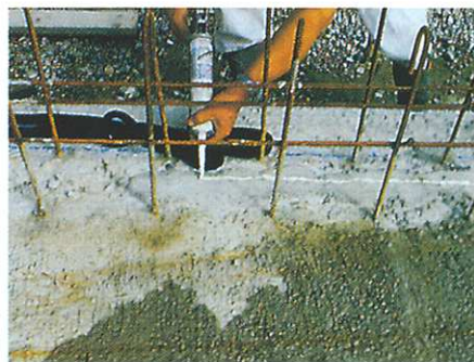
2. PŘIPEVNĚNÍ: VANDEX QUELLBAND KLEBER nanést na čistý, těsný a nerovný povrch.
