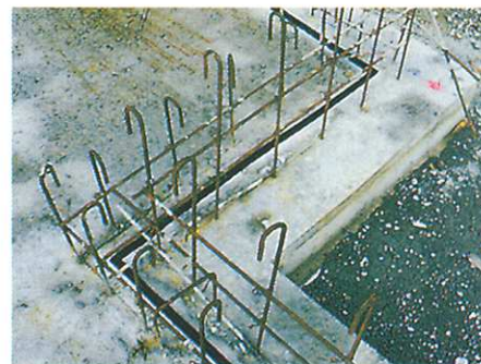
6. Nalepený VANDEX EXPASEAL QUELLBAND nechat 1 den vytvrdnout a přitom chránit před mrazem a horkem. Optimální rozsah zpracovatelských teplot: +10°C - 40°C.
