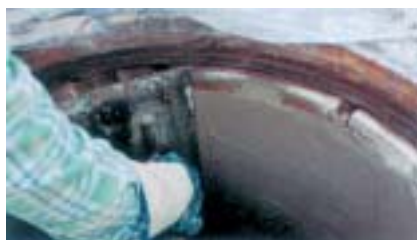
4. reprofilace šachty pomocí VANDEXu UNIMÖRTEL 1 Z
