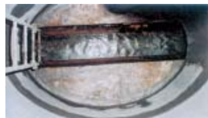
6. pohled na sanovou kontrolní šachtu
