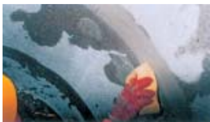
5. vyhlazení VANDEXu BB 75 Z pomocí houby
