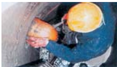
2. utěsnění netěsných a poškozených vstupů rour
